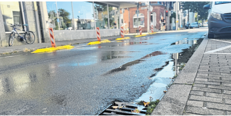
Dienstagmorgen wurde die Hauptleitung in der Friedrichstraße zwischen Bäckerei Utz und Metzgerei Back geprüft. Das Wasser läuft hier gerade ab. BILD: NOAH ESCHWEY
